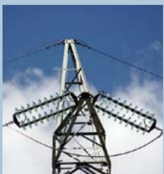
Nella foto in alto a destra, il Security Operation Center; sotto, lavori di manutenzione di una linea elettrica. Qui a destra, una stazione elettrica.
